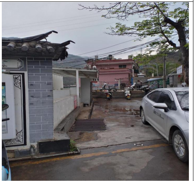
加油站西北面
